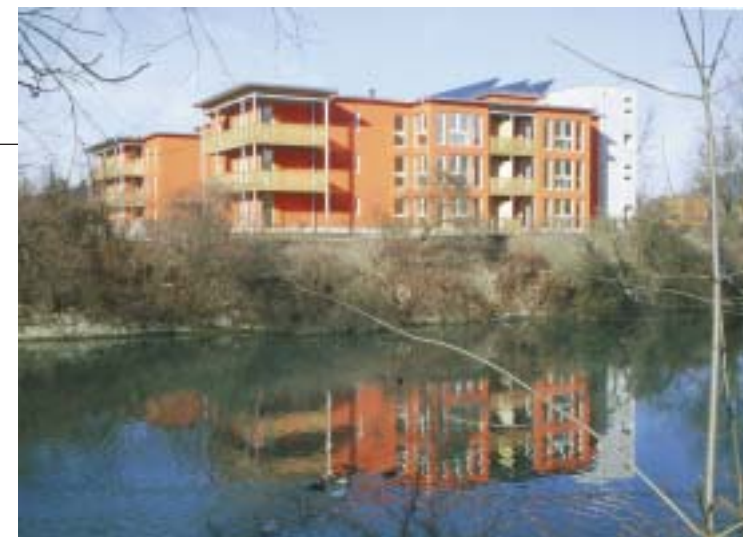
Deze goed geïsoleerde flats in Hallein (Oostenrijk) zijn uitgerust met zonnecollectoren voor warm water, gecontroleerde ventilatie met warmteretourwinning en een pelletgestookte kachel. Een 30 kW installatie is groot genoeg om dit project van 2300 m 2 te verwarmen. Totale kosten van het project: 323 EUR/m 2 . Details van dit project staan op www.cepheus.at .
